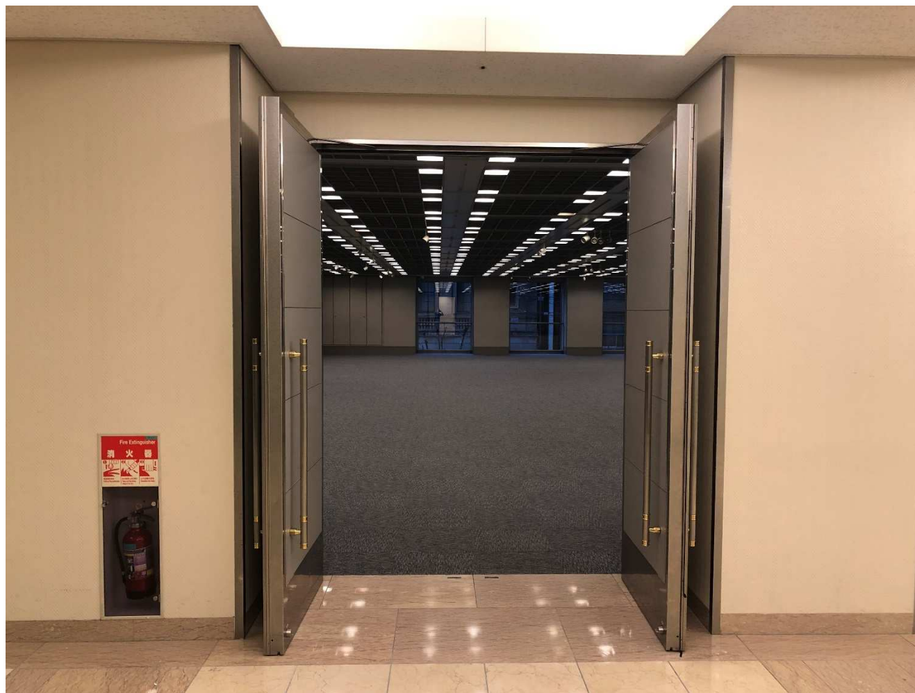
2階ホールB 搬入出扉(ホワイエ側) W1650(取手有 W1500) H2350
